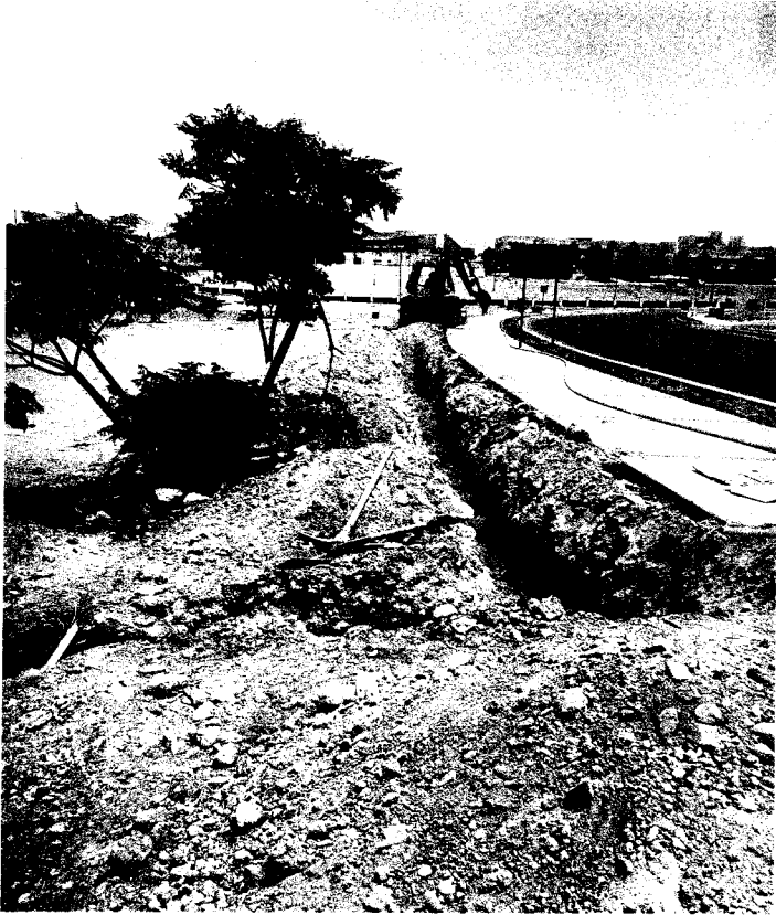
Afine de excavacion en cepa
