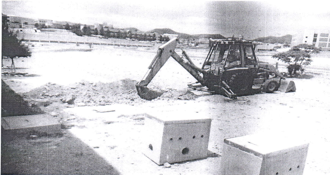
Suminsitro e instalacion de registro electrico prefabricado tipo RBTB1
