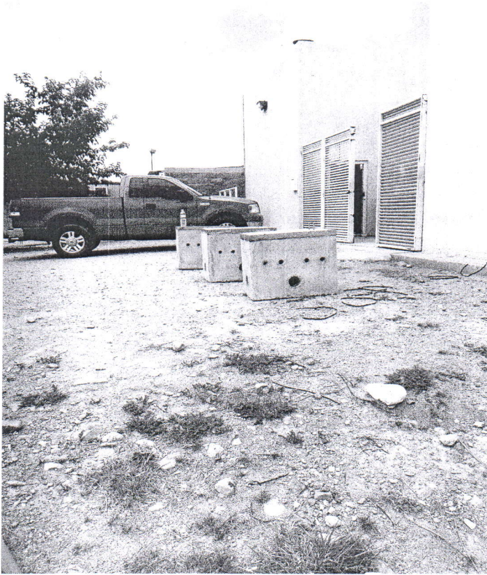
Suminsitro e instalacion de registro electrico prefabricado tipo RBTB1
