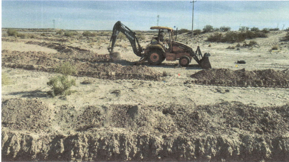
Imagen 20. Elaboración de tinas ciegas con maquinaria
