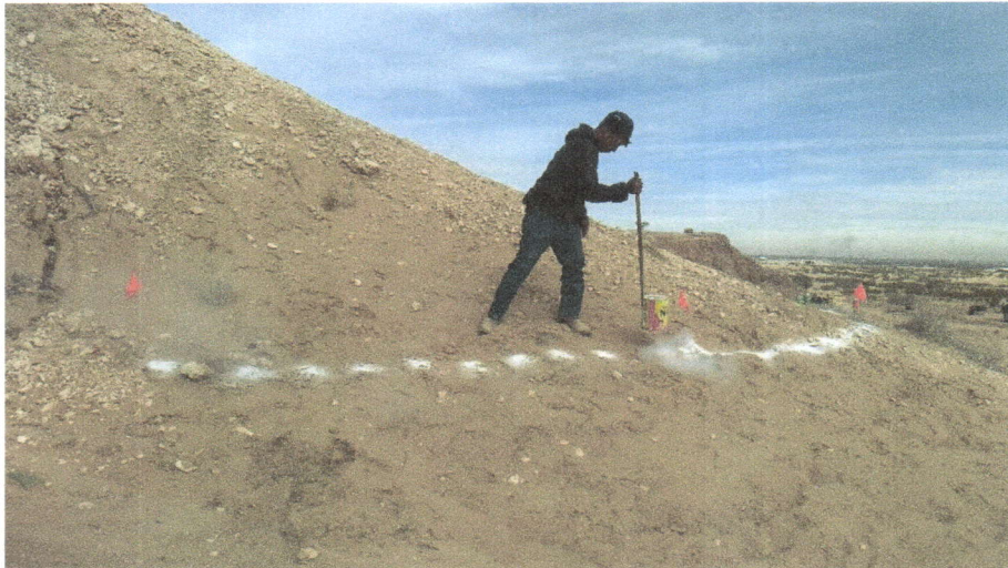
Imagen 3. Señalización de curvas a nivel
