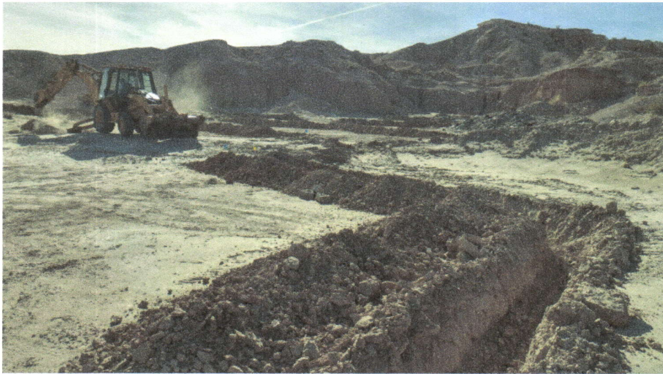
Imagen 21. Proceso de elaboración de tinas ciegas con maquinaria
