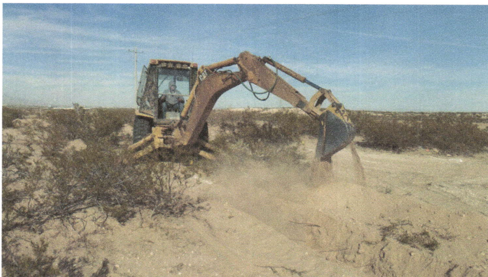
Imagen 22. Excavación de la zanja
