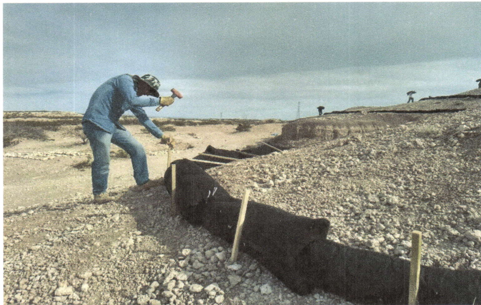
Imagen 13. Colocación de estacas para estabilizar los geo-costal en la pendiente
