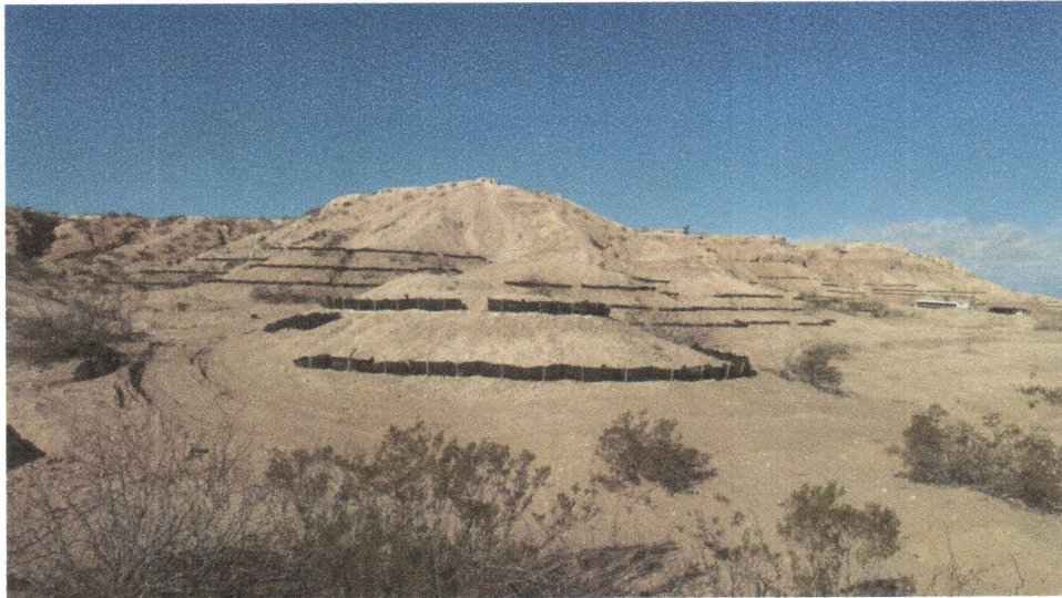
Imagen 16. Vista panorámica de los cordones de geo-costales
