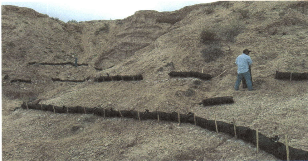
Imagen 12. Acomodo de geo-costal sobre curva a nivel
