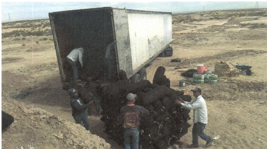
Imagen 9. Apilamiento temporal de geo-costales
