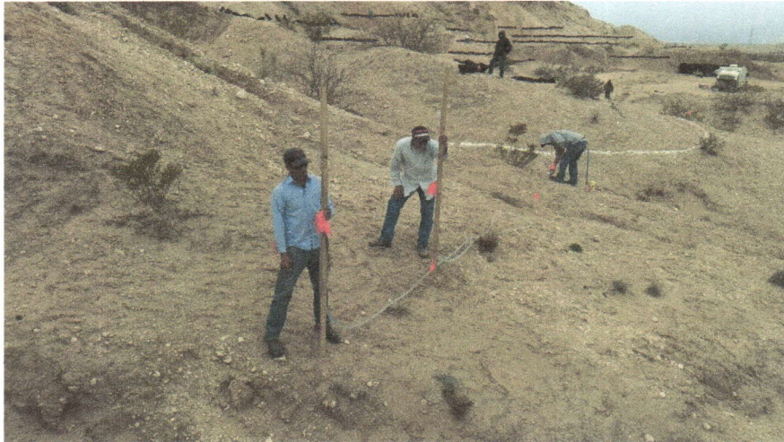
Imagen 1. Trazo de las curvas a nivel para colocación de geo-costales.
