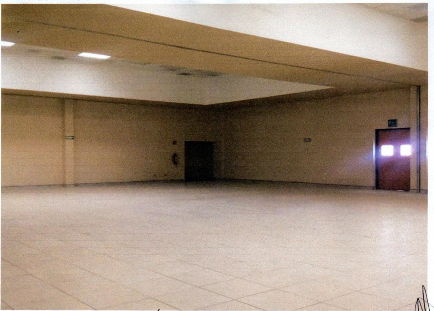
INSTALACION CERAMICA SEWITARIOS
